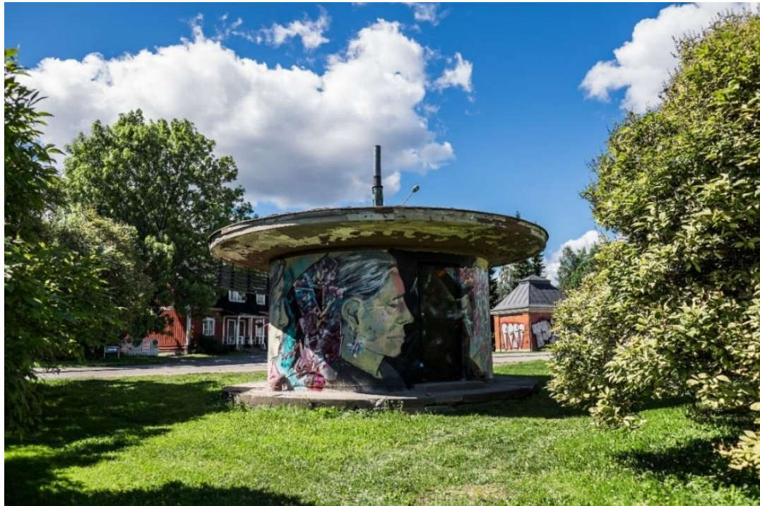
Vasemmalla kunnalliset rivitalot, edessä kioski ja oikealla muuntamo
