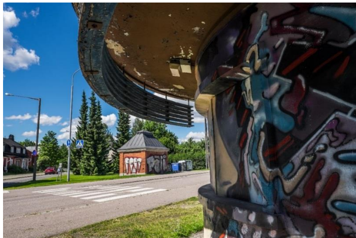
Muuntamo lankarullakioskilta kuvattuna
