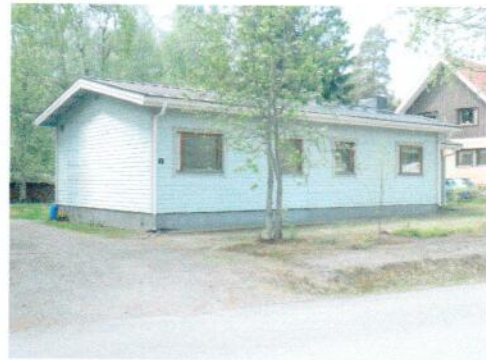
Vuoritie 9 Rakennuksesta 1/2 peruskallion päällä pohj.
