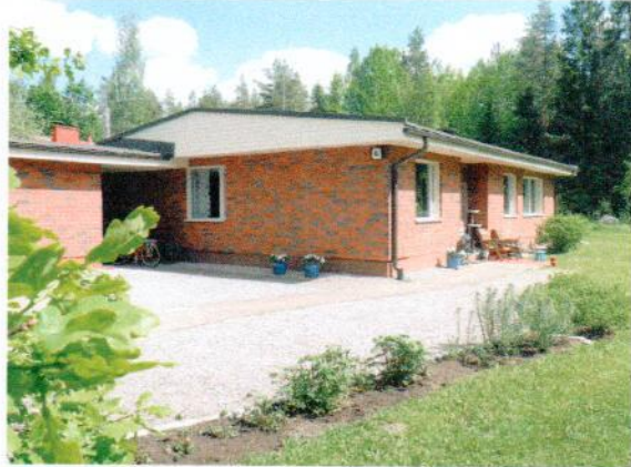
Vuoritie 10 1/3 osa perustuksesta peruskallion päällä ohut sorakerros anturan alla.
