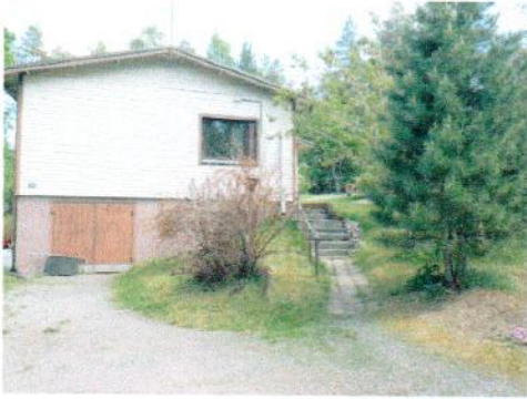
Vuoritie 16 Rakennuksesta 2/3 peruskallion päällä
