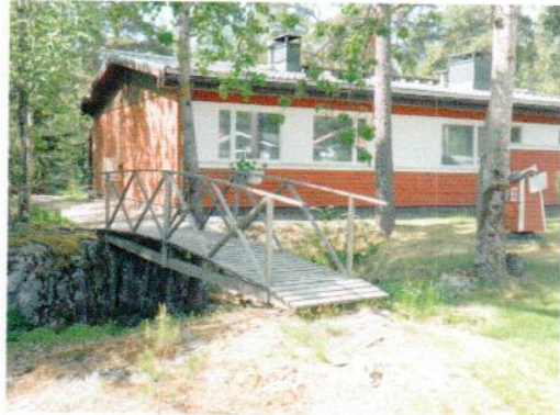
Vuoritie 15 Rakennuksesta 1/2 peruskallionpäällä.
