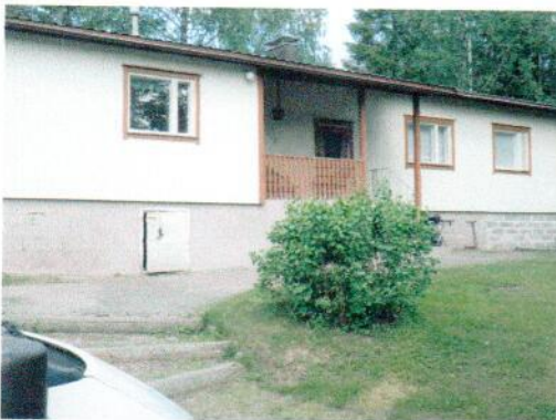
Vuoritie 24 Rakennuksesta 3/4 peruskallion päällä.
