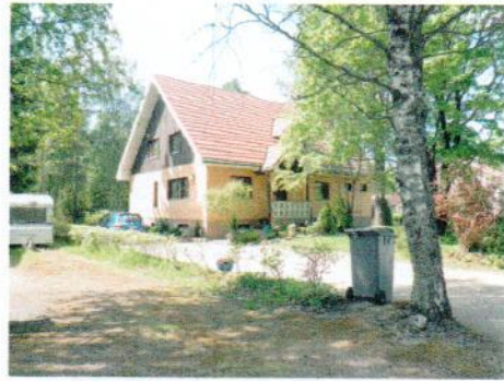
Vuoritie 11 Rakennuksesta 1/2 peruskallion päällä
