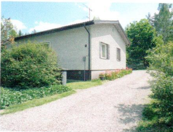
Vuoritie 8 1/2 peruskallion päällä itäsisivu, eteläpuoli kok.
