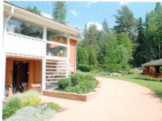
Vuoritie 12 2/3 rakennuksesta peruskallion päällä Osa betonipilarien varassa.
