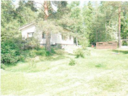
Vuoritie 20 Rakennuksesta 1/2 peruskallion päällä
