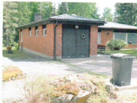
Vuoritie 26 Rakennuksesta 1/2 Peruskallion päällä.
