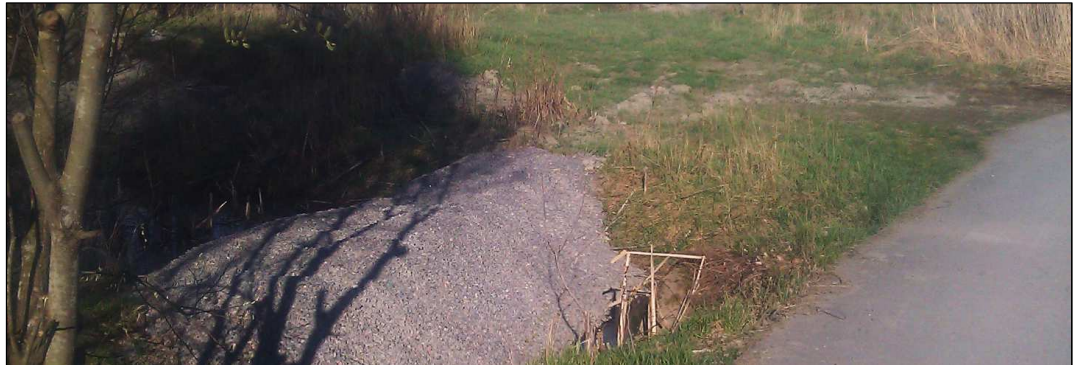
Kuva 9. Avo-ojan eteen rakennettu väliaikainen suodattava murskepato. Turku, Haarlanlahti. 13
