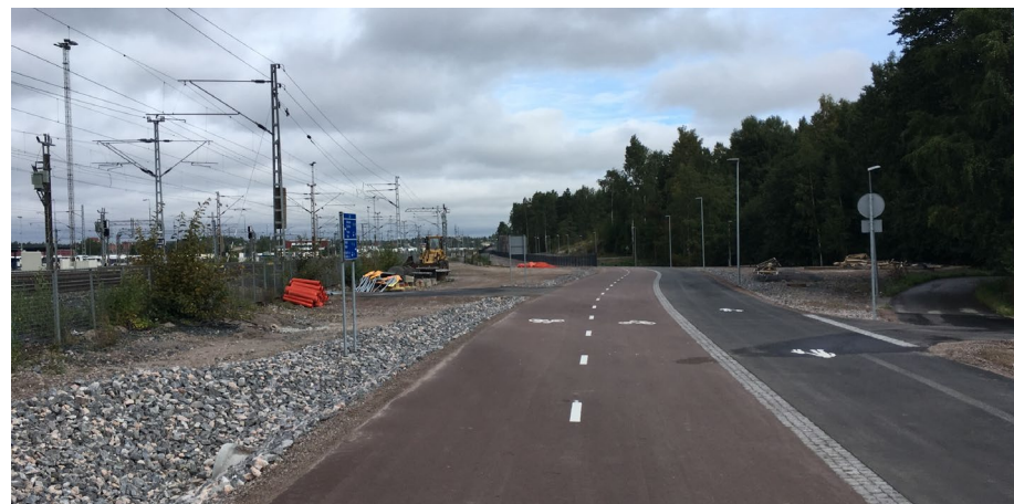
Kuva 10 Hillitty punasävy selkeyttää liikenneympäristöä - pyörätie on helppo tunnistaa.
