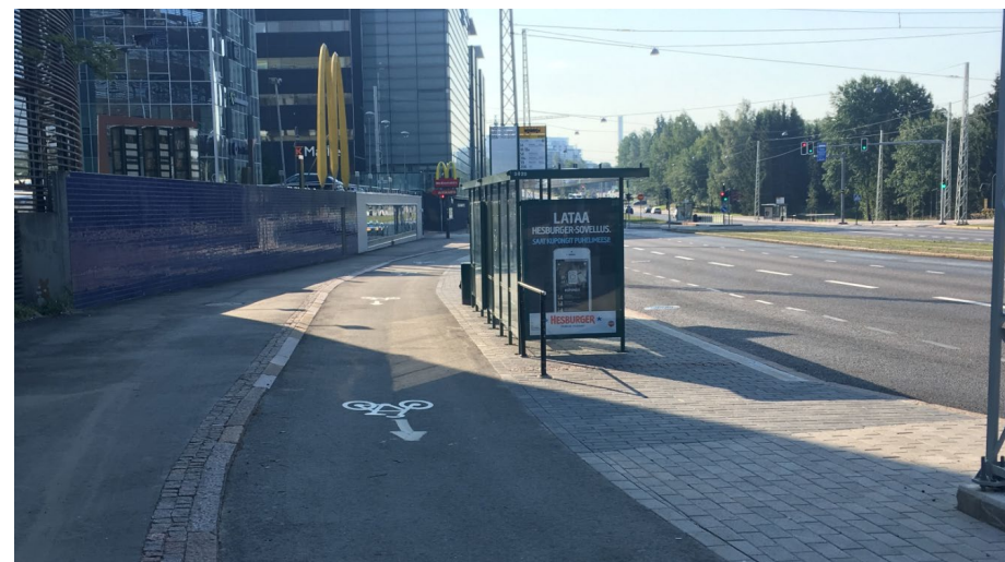
Kuva 3 Pyörätien ja jalkakäytävän välissä oleva reunakivi tuottaa selkeän ja ymmärrettävän liikennenympäristön. Reunakiven havaittavuutta voidaan korostaa kahden noppakiven raidalla.
