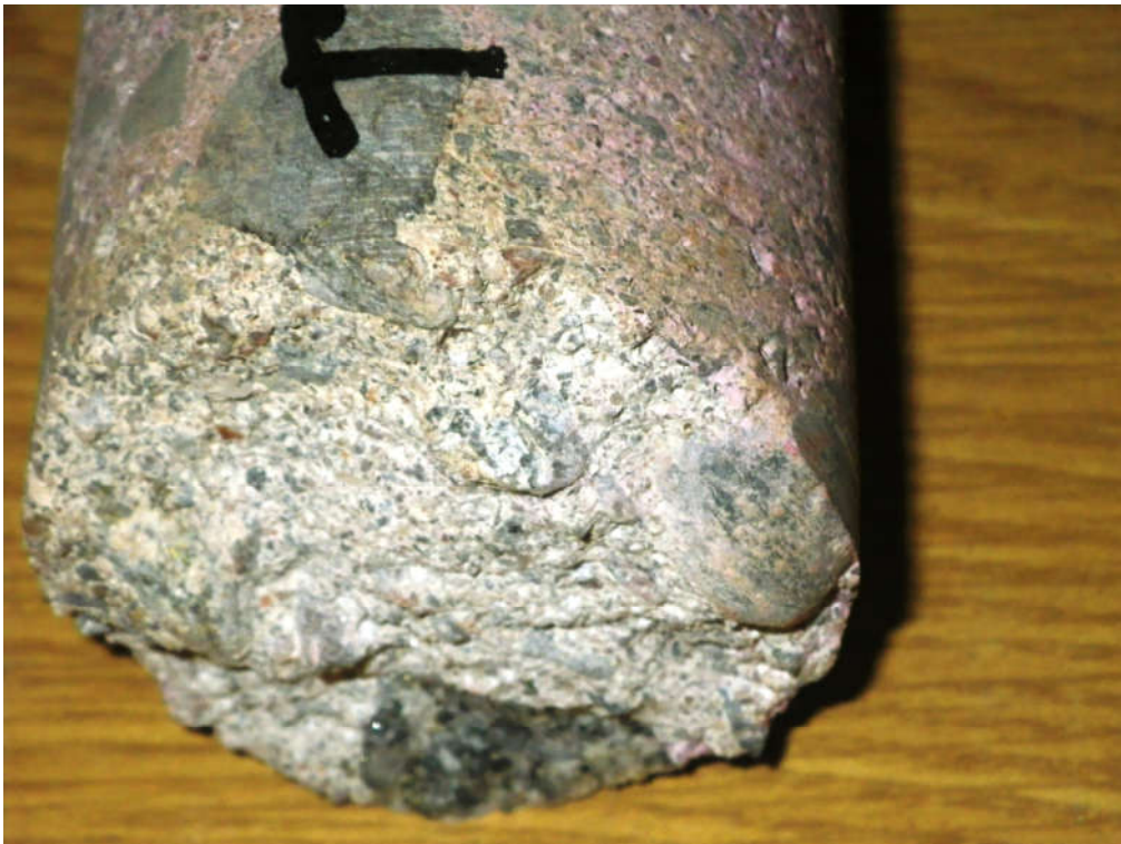
Kuva 2. Lähikuva piipun jalustan betonista poratusta näytteestä; porauspinnan huokoisuus johtuu ohuthietutkimuksessa mainituista betonin valmistusvaiheen puutteista / virheistä
