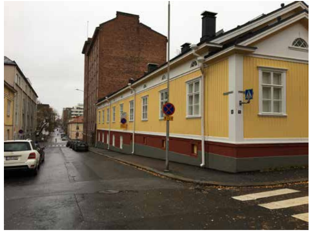
As. Oy Erkkilän-Aukeen julkisivu Aleksanterinkadulle.
