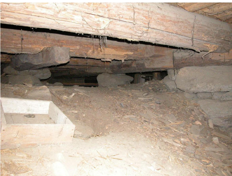
Päärakennuksen perustus on tehty perinteisesti luonnonkivipilareiden varaan.
