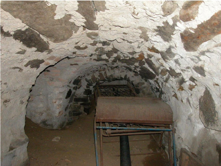
Vanhan kellarin tiiliholvit. Kellari sijaitsee rakennuksen eteläsiivessä pääkuistin vieressä. Holvaus on etelä-pohjois – suuntainen, ja siitä on johtanut sivuhaara vasemmalle
