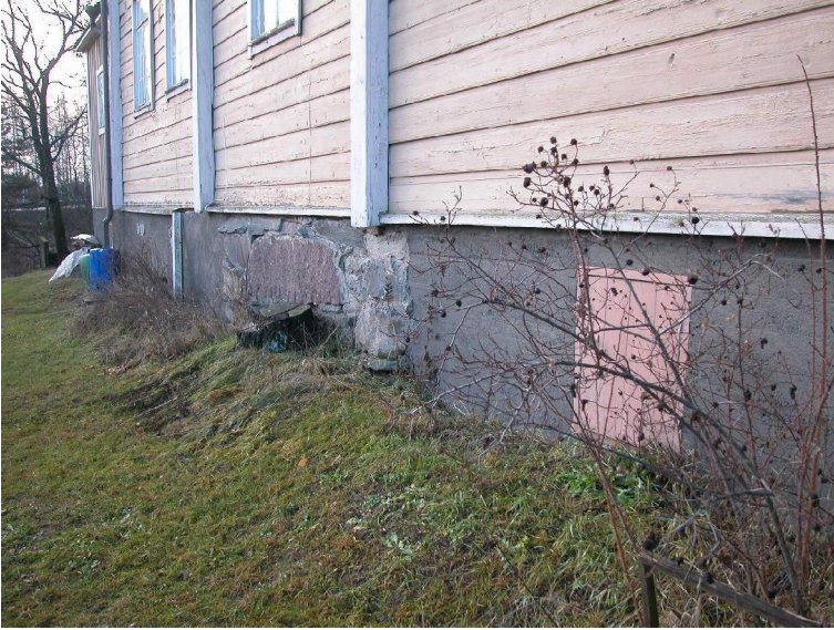
Takasivun sokkeli. Vanhan kellarin sivuhaaran pääty näkyy keskellä.
