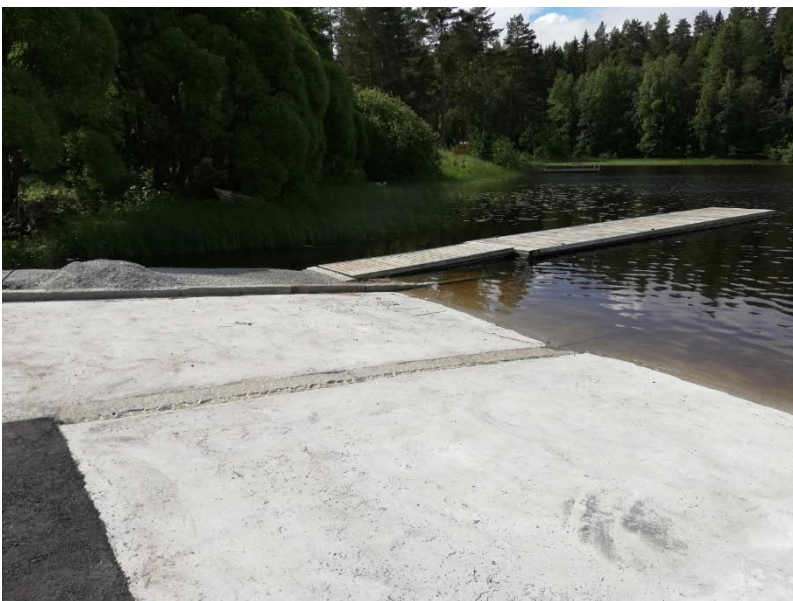
Kuva 5 Maisansalon luiska 2.7.2019. Murskekasa luiskan vasemmalla puolella on vielä tasaamatta, koska lämmityskaapeleita ei ole vielä kytketty.
