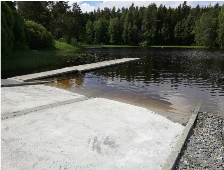
Kuva 4 Luiskan yleisilme ja betonipinnan puhtaus tarkastuksen yhteydessä tiistaina 2.7.2019.
