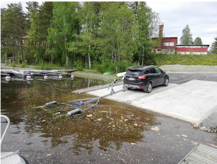
Kuva 3 Luiskan toimintaa tarkasteltiin satunnaisten käyttäjien laskiessa veneitään veneluiskasta. Vetoauton takapyörät jäivät selvästi kuivalle maalle trailerin ollessa jyrkemmällä vedenalaisella luiskanosalla jo riittävän syvällä venettä laskettaessa. Vedenkorkeus kuvan ottohetkellä 24.5.2019 vastasi hyvin vesistön pitkän ajan keskiveden korkeutta +95,61 m. Luiskan taitos on täsmätty pitkän ajan keskivedenkorkeuteen.
