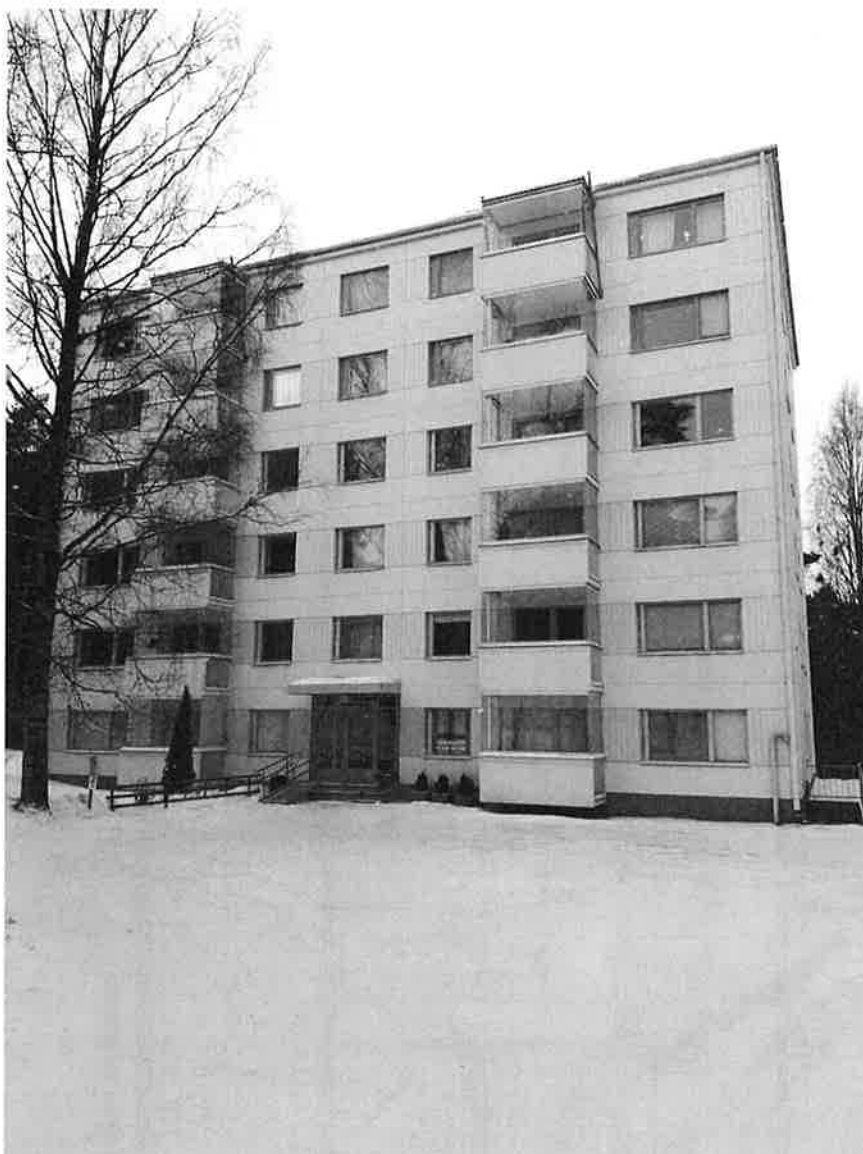
Kuva 5. Tornirakennus etupiha (Suunta A). Parvekkeiden välillä pystysuunnassa parvekkeiden välillä mahdollista tupakansavun kulkeutua ja niiden kautta huoneistoihin. Parvekkeiden välittömässä läheisyydessä myös tuuletusikkunoita, joiden kautta tupakansavulla mahdollista kulkeutua huoneistoihin sisälle. Jokaisessa etupihan ikkunassa tuuletusikkuna.
