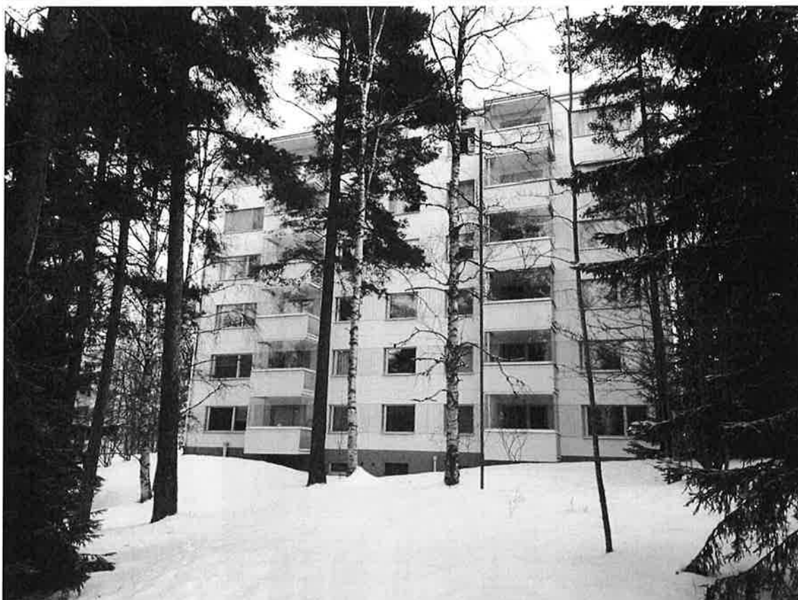
Kuva 6. Tornitalon takapiha (Suunta C). Päällekkäisten parvekkeiden välillä mahdollista savun päästä kulkeutumaan parvekkeelta toiselle. Tuuletusikkunoita myös parvekkeiden välittömässä läheisyydessä, joiden kautta tupakansavulla mahdollista päästä huoneistoihin. Takapihan seinällä vanhojen "kylmäkaappien" venttiileitä, joiden kautta tupakansavu mahdollisesti pääsee huoneistoon. (Kylmäkaapin venttiileitä esimerkiksi punaisella viivalla osoitetulla pystylinjalla.
