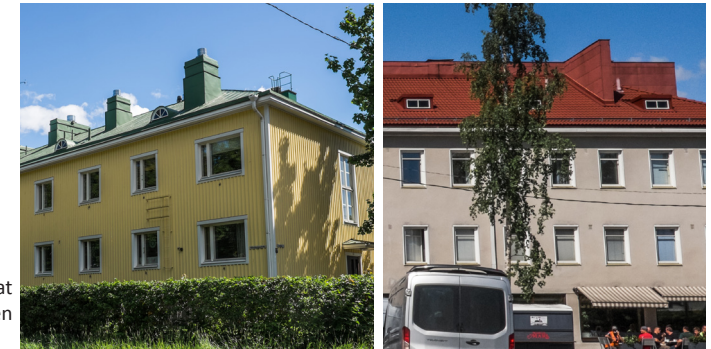
Lunetti-ikkuna ja pieni pulpettikattoinen ikkuna kerrostalojen katoilla.
