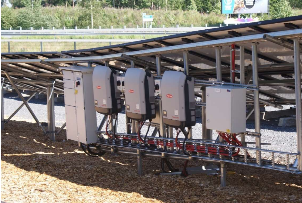
Kuva 6. Periaatekuva aurinkovoimalan invertterien asennuksesta
