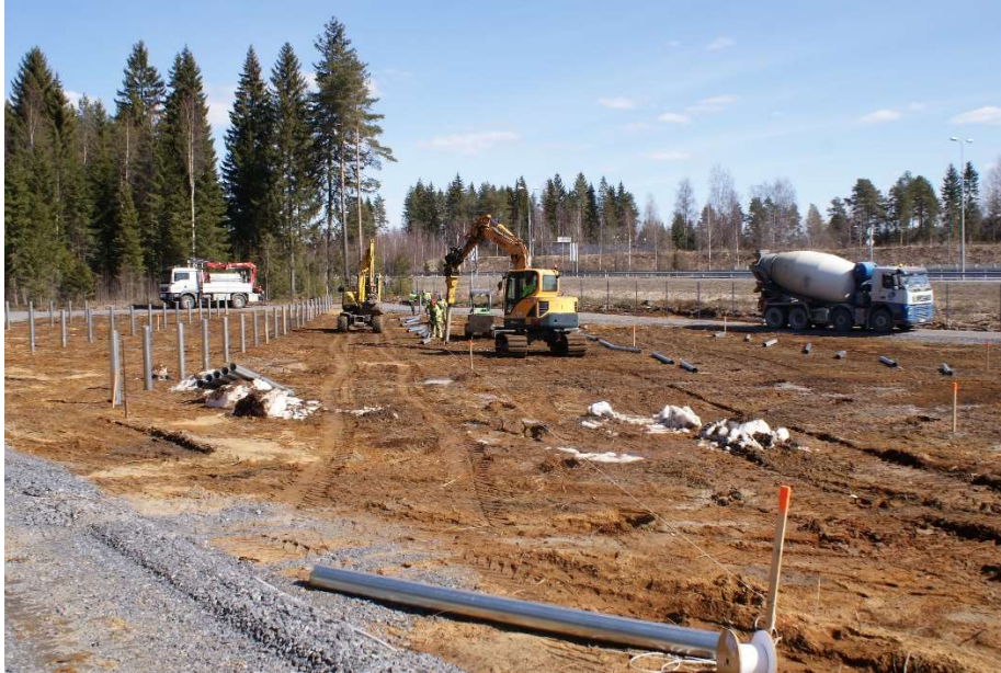
Kuva 3: Finnwind Oy:n suunnittelema ja toteuttama aurinkovoimalan pilarien asennus
