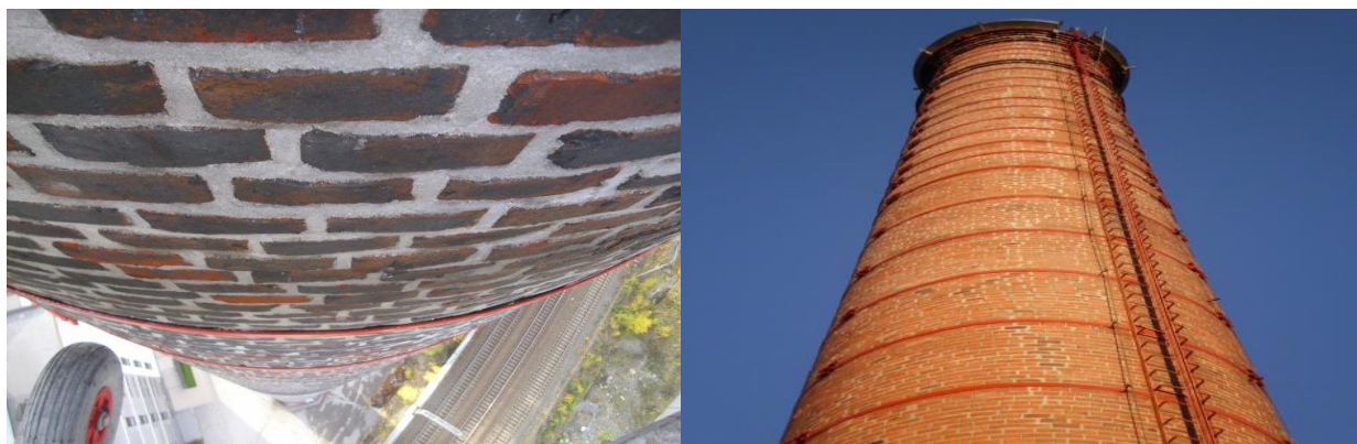
Kuvat: Tavoite piipun korjauksien jälkeen.
